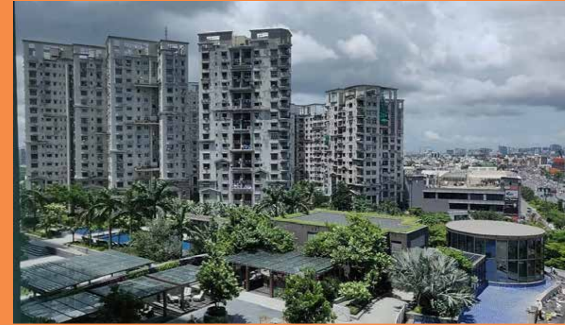
Silver Spring, EM Bypass
