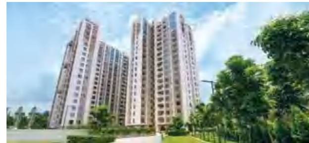
Ozone South EM Bypass
