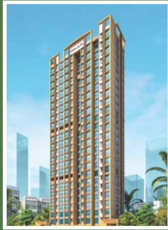
BLDG NO.74 - KANNAMWAR NAGAR
