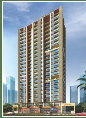
BLDG NO.98 - KANNAMWAR NAGAR
