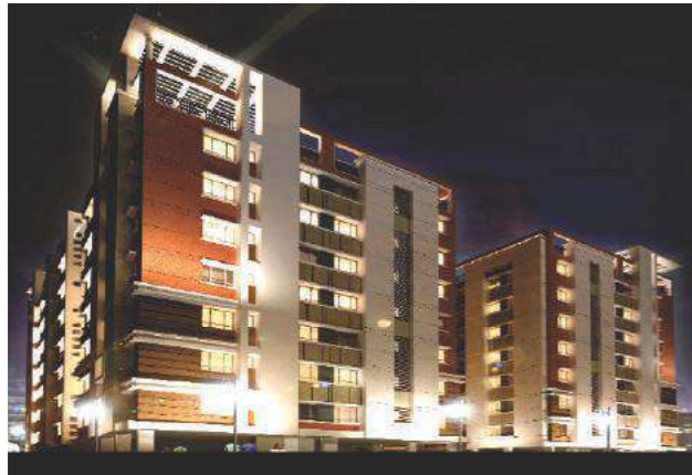
Merlin Crest, DH Road - Silpara
