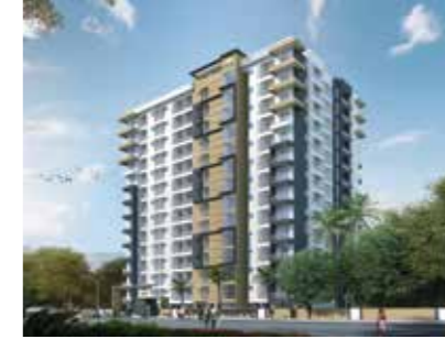
Sowparnika Edifice Thrissur
