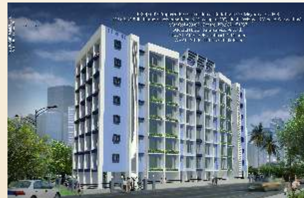
MEGHDOOT BLDG. NO. 73, KURLA (E)
