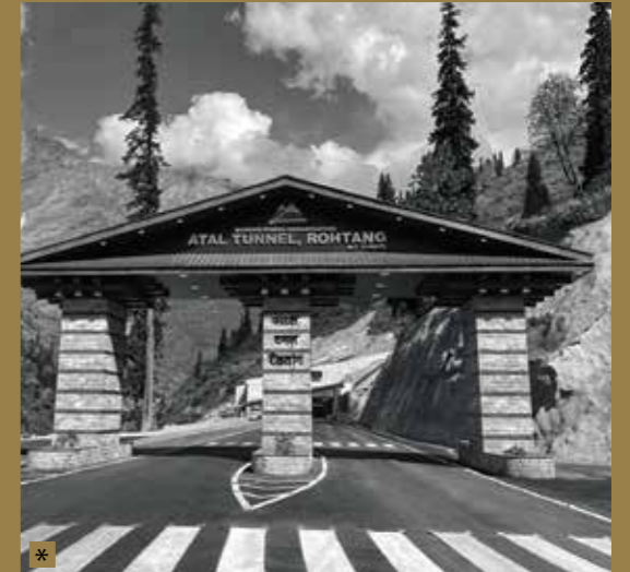
ATAL TUNNEL, ROHTANG
