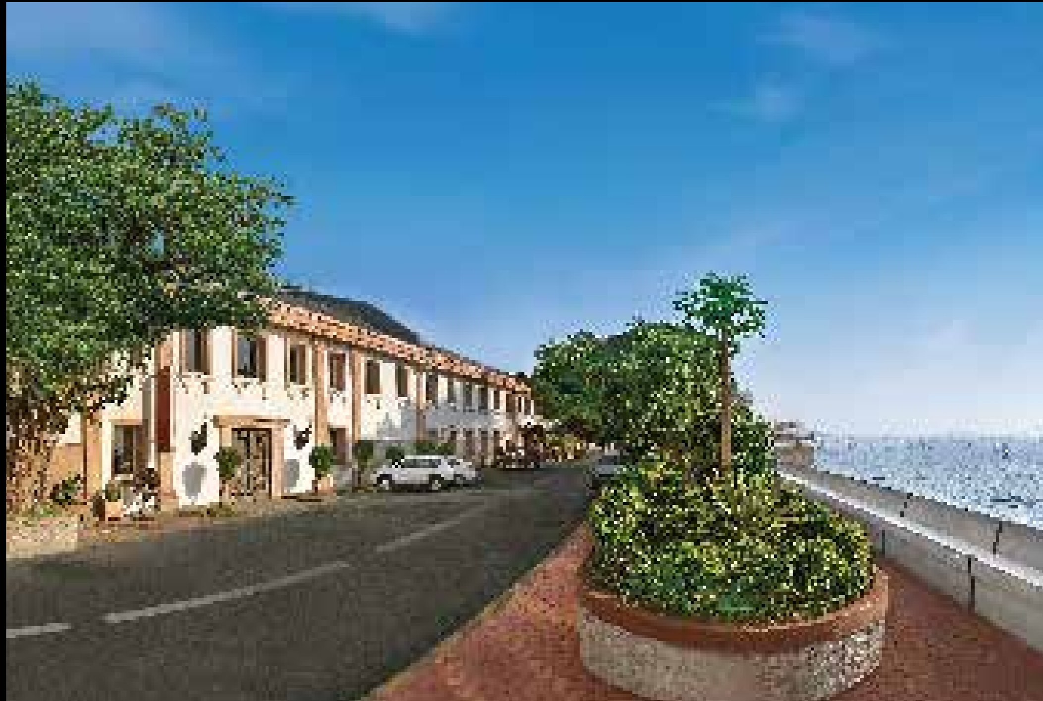
ACTUAL IMAGE OF SP CENTRE, COLABA-MUMBAI
