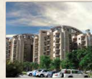
ATS PRELUDE Dera Bassi
