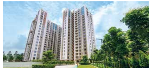
Ozone South EM Bypass
